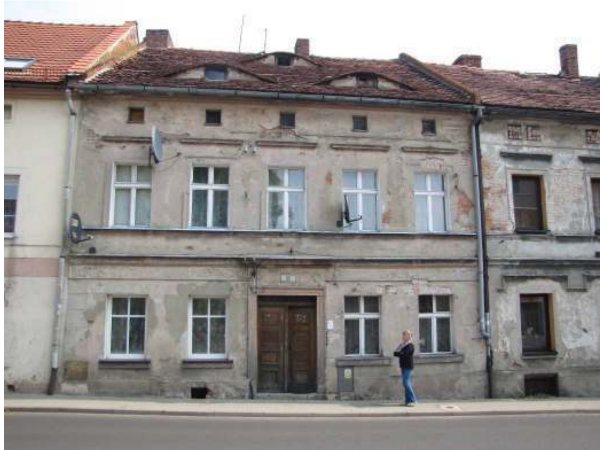
Fot. Elewacja frontowa
