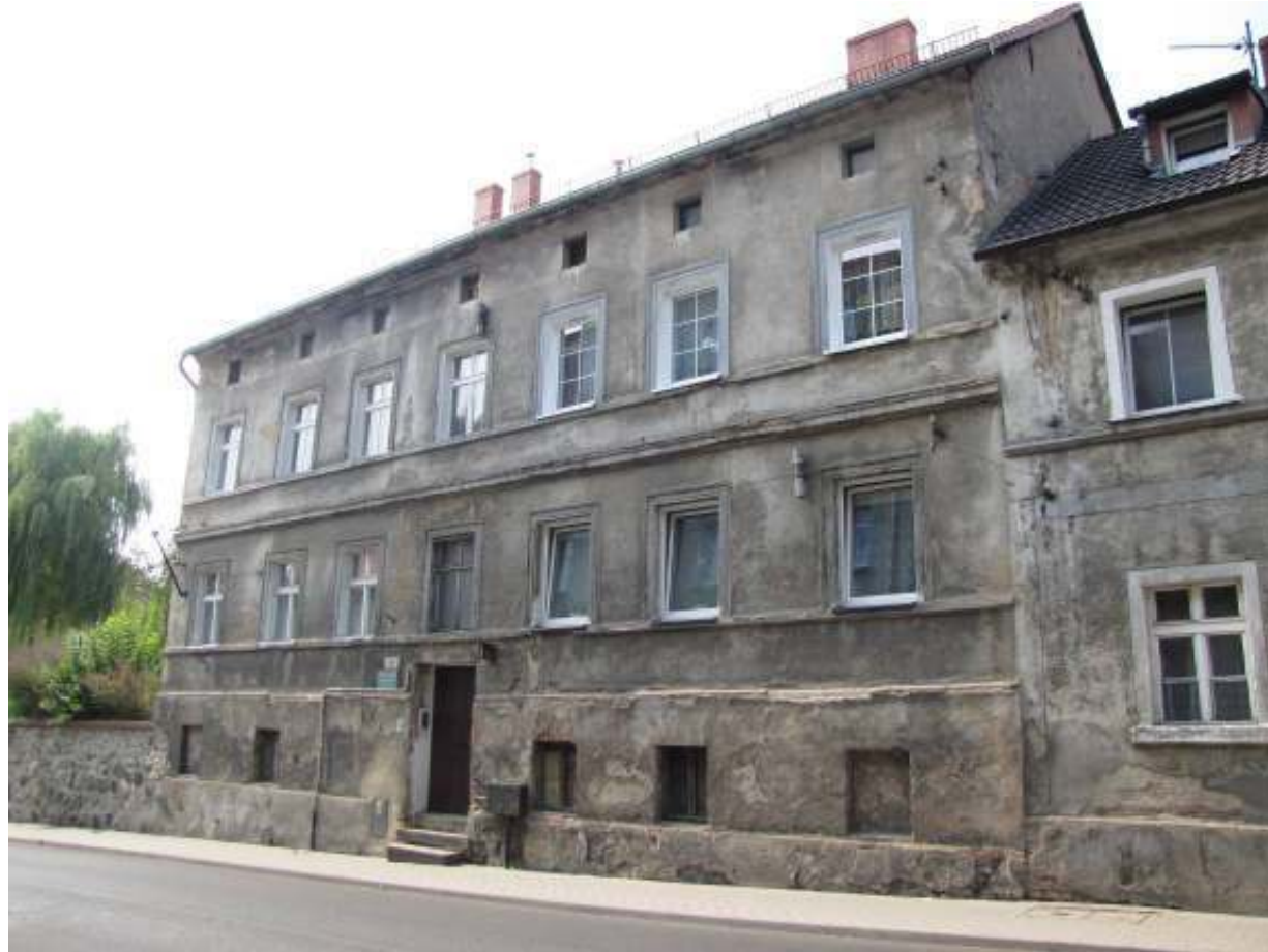
Fot. Elewacja frontowa
