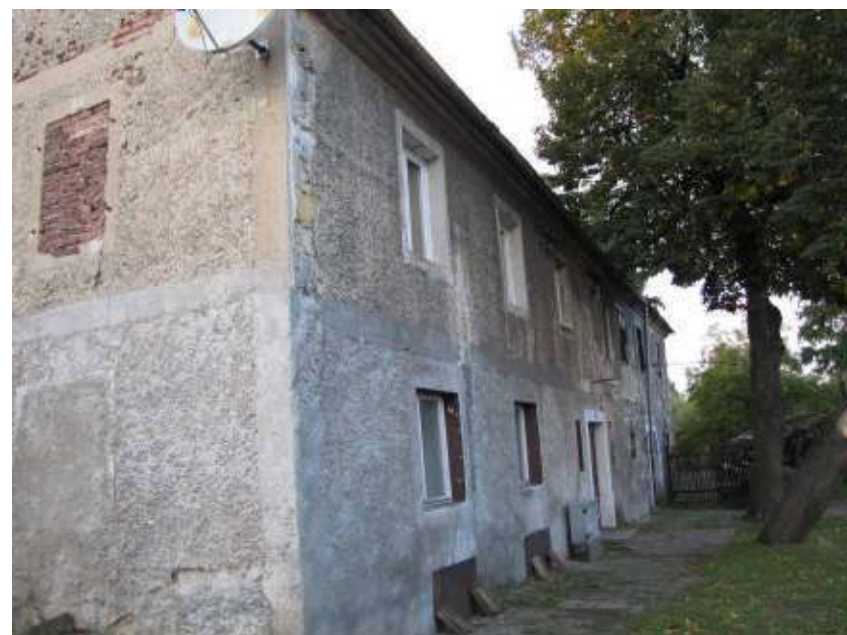
Fot. Elewacja boczna
