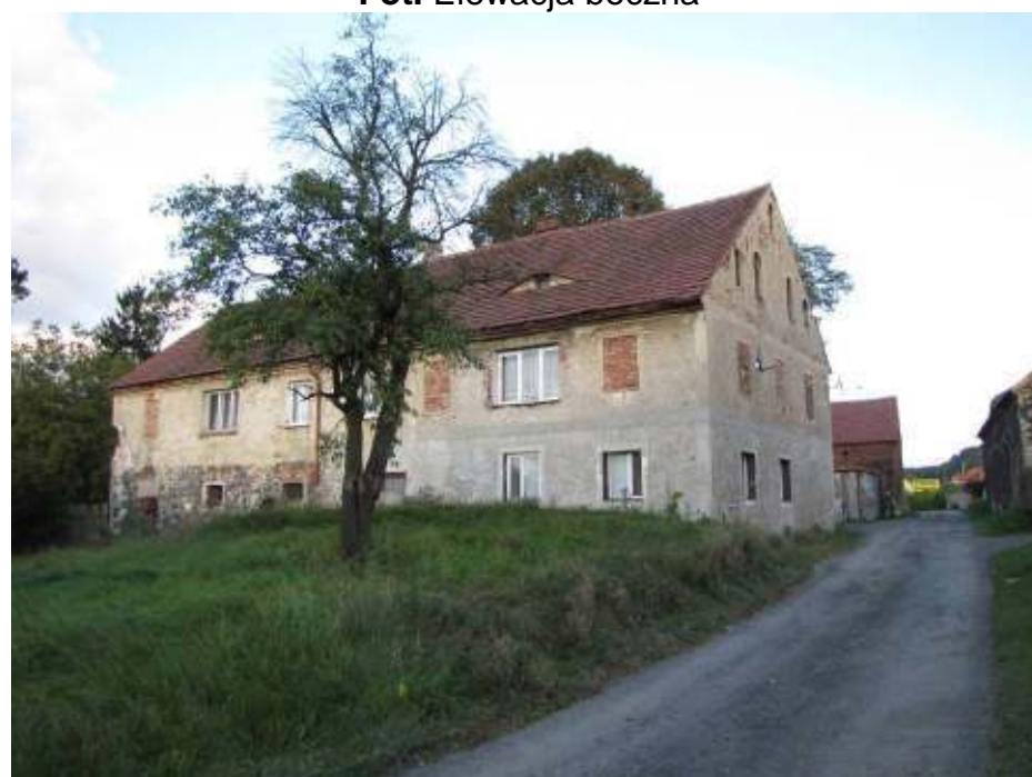
Fot. Elewacja frontowa
